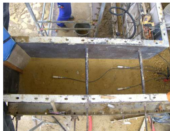
Maison de St-Antoine l'Abbaye : les sondes d'humidité relative et température (à gauche) et de teneur en eau (à droite) positionnées dans les murs en pisé.
