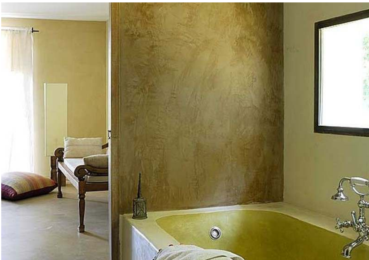
Mur de douche en enduit stuc marmorino - Les trois matons
