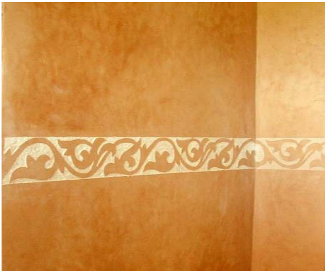
Frise en enduit gratté : Photo L'atelier Pittoresque *
