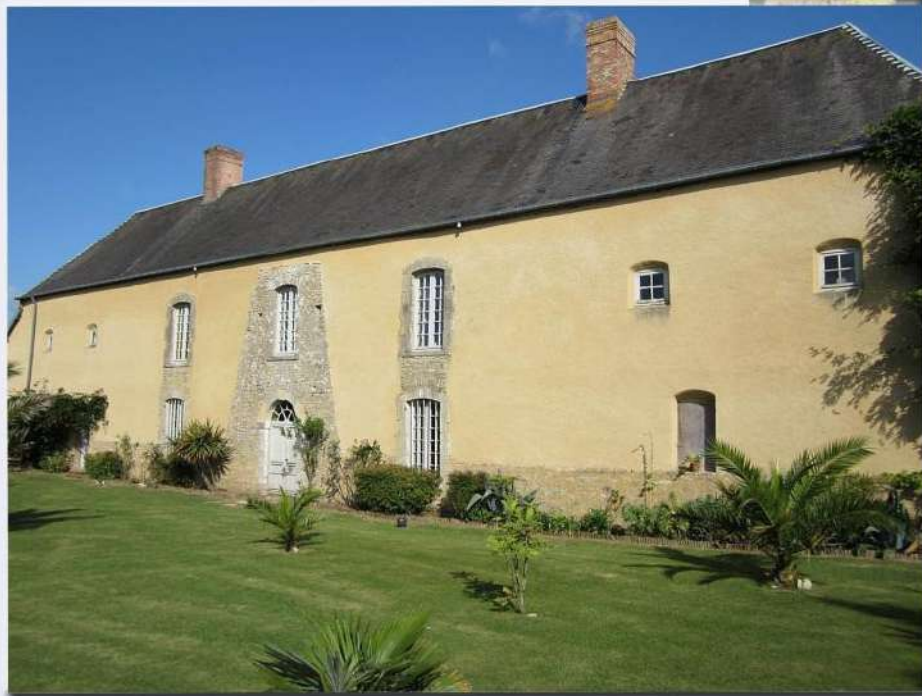
Manoir de Donville_- Construit au XIe siècle Dép. de la Manche (Normandie)
