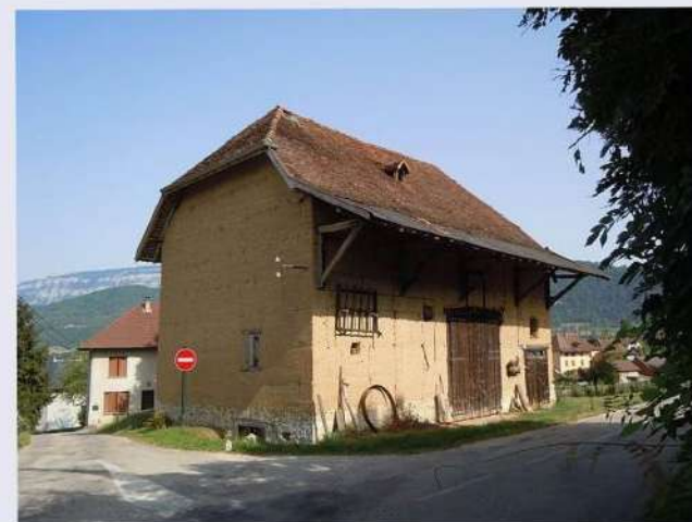
Grange en pisé, Saint-Albin-de-Vaulserre, Isère, Rhône-Alpes
